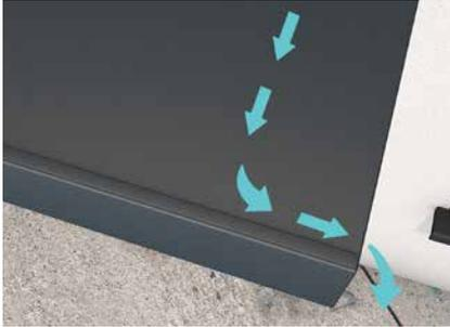
Das Regenwasser wird von der vorderen Schwalleiste aufgefangen und seitlich abgeführt.
